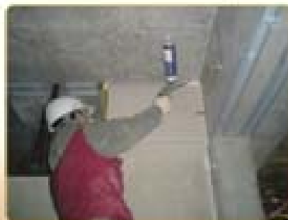
5- Filling Urethane Foam ۵- درز گیری
