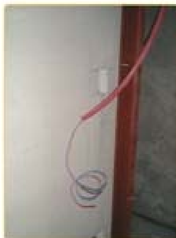
7- C shape steel installation ۷- جایگذاری لوله فرغوسی جهت برق و تلفن
